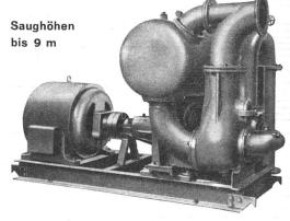
Leistungen 1-500 Liter/Sek. Kein Bodenventil. Keine Klappe im Saugstutzen. Keine Hilfs-Vakuum-Pumpe. Jederzeitiges automatisches Ansaugen auch nach Lufteintritt im Saugrohr. Keine reibenden, sich abnützenden Dichtungsflächen, daher unempfindlich gegen Sand, Schlamm und Kies.
