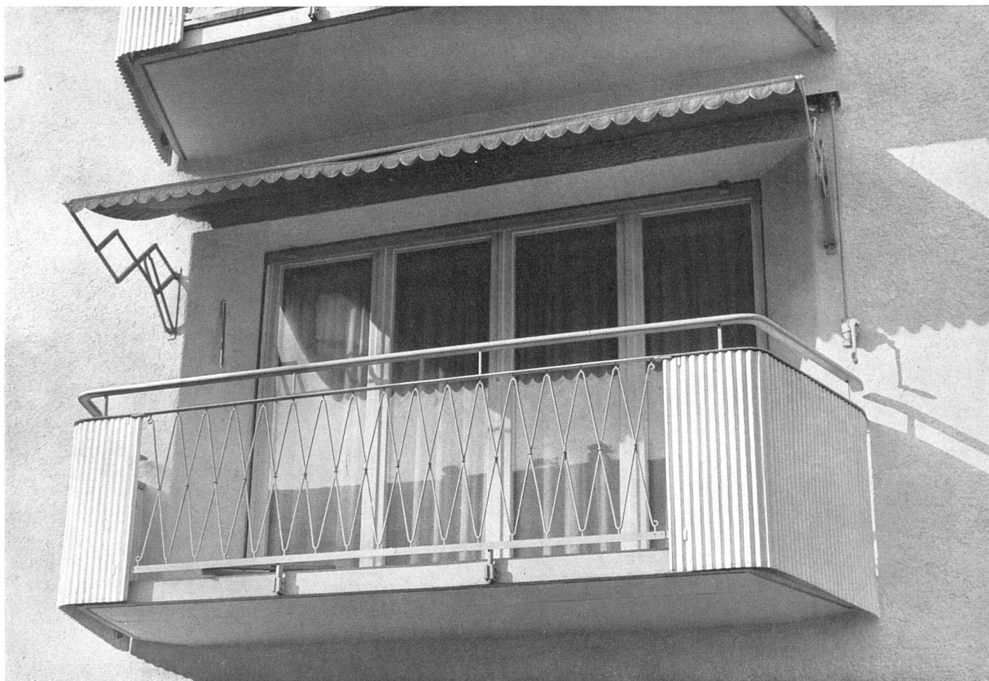
Wohnungsbalkon aus Eisen und Welleternit / Balcon en fer et «Eternit» ondulé / Balcony of steel and corrugated asbestos-cement
