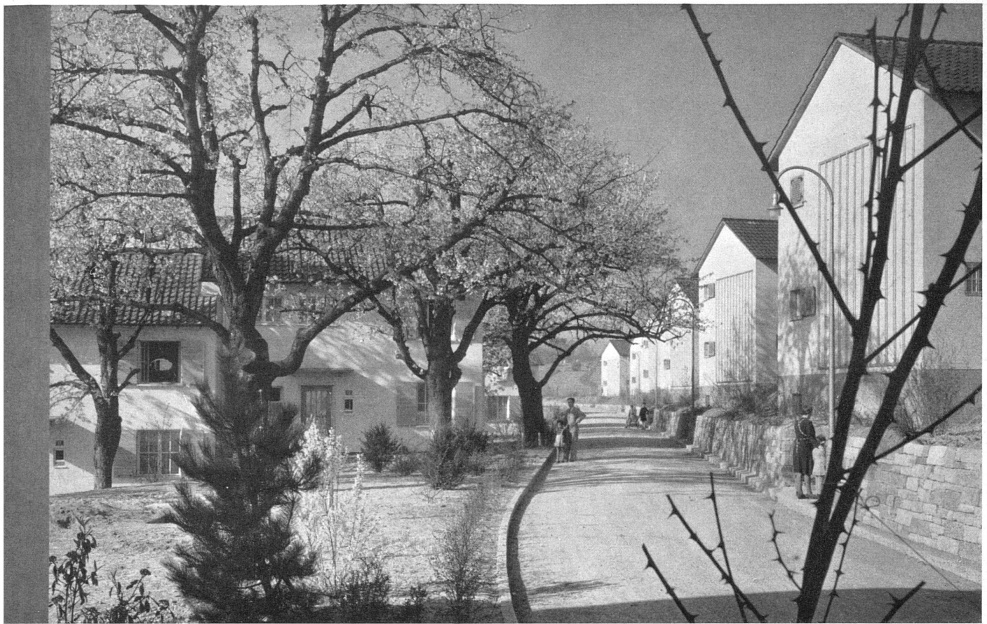
Siedlungsstraße. Links Haustyp D, rechts C | Une rue dans la cité. À gauche type D, à droite type C | Typical street. Left houses type D, right type C
