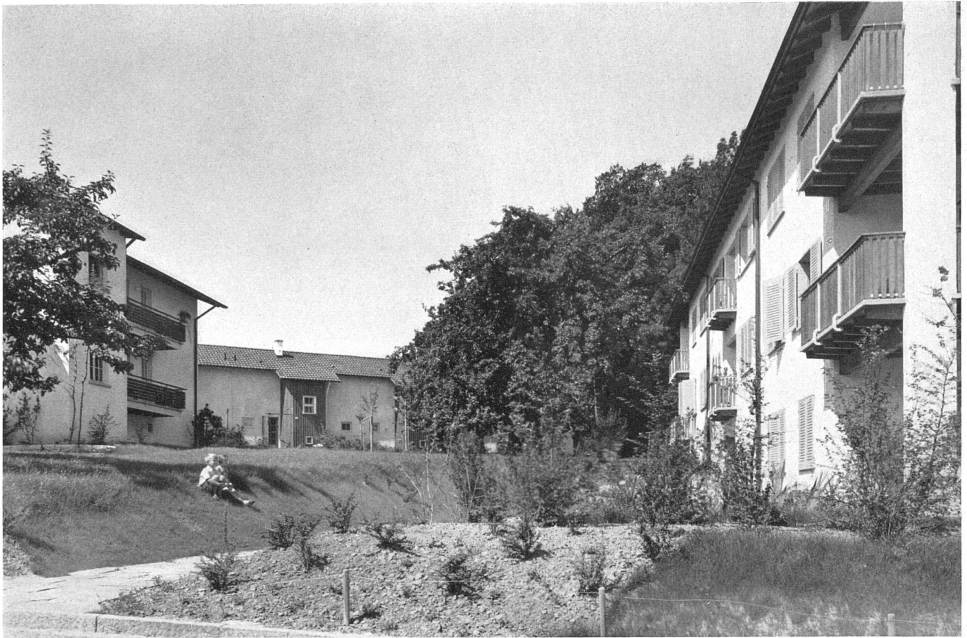
Laubenganghäuser M, im Hintergrund Einfamilienhaus A / Maisons à galeries d'accès, type M; à l'arrière-plan, les maisons familiales, type A / Blocks with access galleries M, in the background terraced houses A
