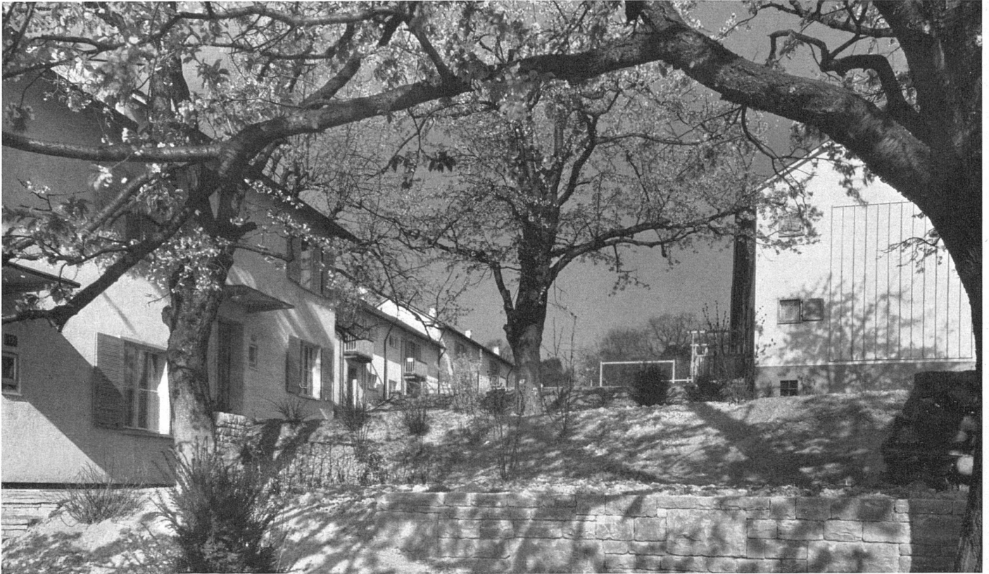
Siedlung Jakobsberg, Basel, H. Baur, Arch. BSA. Gartenhof mit Einfamilienhäusern C und D | Cité-jardin «Jakobsberg» | «Jakobsberg» housing scheme
