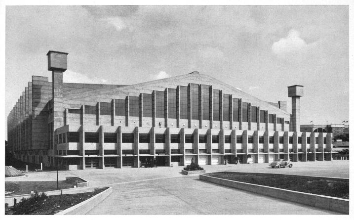
Eingangsfront, links und rechts Wasserreservoirs / Façade; à droite et à gauche, des réservoirs / Entrance elevation, right and left water tanks
