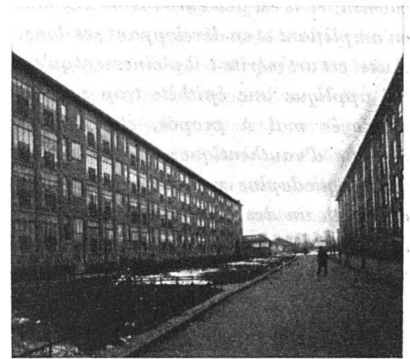
Volkswohnungsbauten, kurz vor dem Kriege erstellt von den Architekten Merkelbach & Karsten. 4 Geschosse, 25 m Gebäudeabstand, 170 m lange Zeilen. Straßenraum. Die Bäume wurden wegen Holz-mangel gefällt
