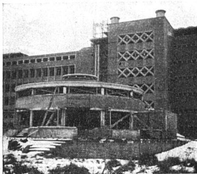
Verwaltungsgebäude der Bataafse Import-Gesellschaft 1939/40, von Architekt J. J. P. Oud. Rückansicht mit runder Personalkantine, Bau stark durch Bomben beschädigt. Streng symmetrische Anlage, Formversuche à la art décoratif
