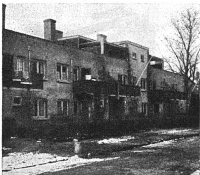
Reihenhäuser, 1920 von Architekt J. B. van Loghem († 1940)
