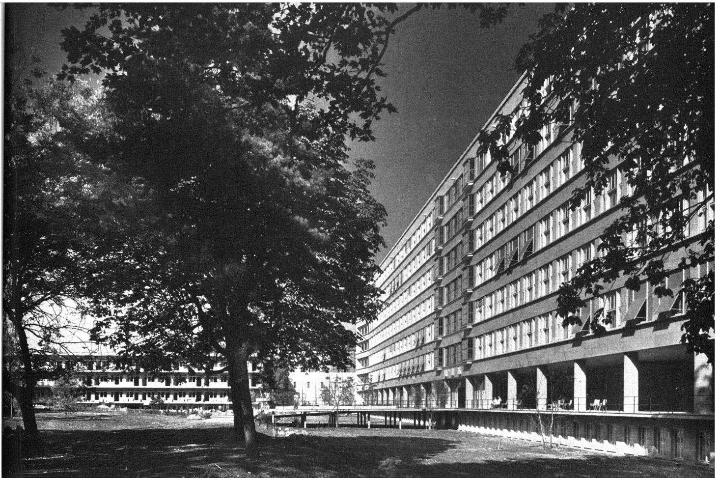
Der Gartenraum, rechts das Bettenhaus, im Hintergrund das noch im Bau befindliche Infektionskrankenhaus Arch. BSA H. Schmi
