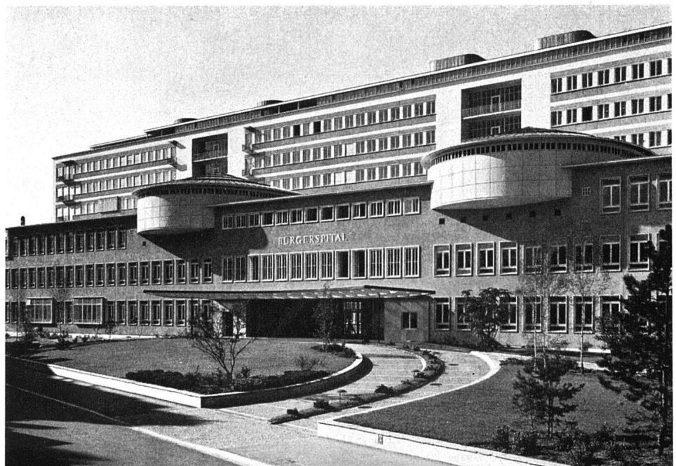
Behandlungsbau mit Haupteingang und Blick auf die Rückseite des Bettenhauses
