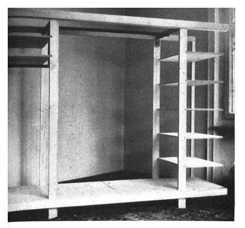
jer Typenschrank, Tragskelett aus Tanne. Kleiderstange links als wträger ausgebildet. Die Wände und Schiebetüren bestehen aus wvatex. Die Vertikalleisten an den Schiebetüren dienen zum Greifen leichzeitig als Versteifung
