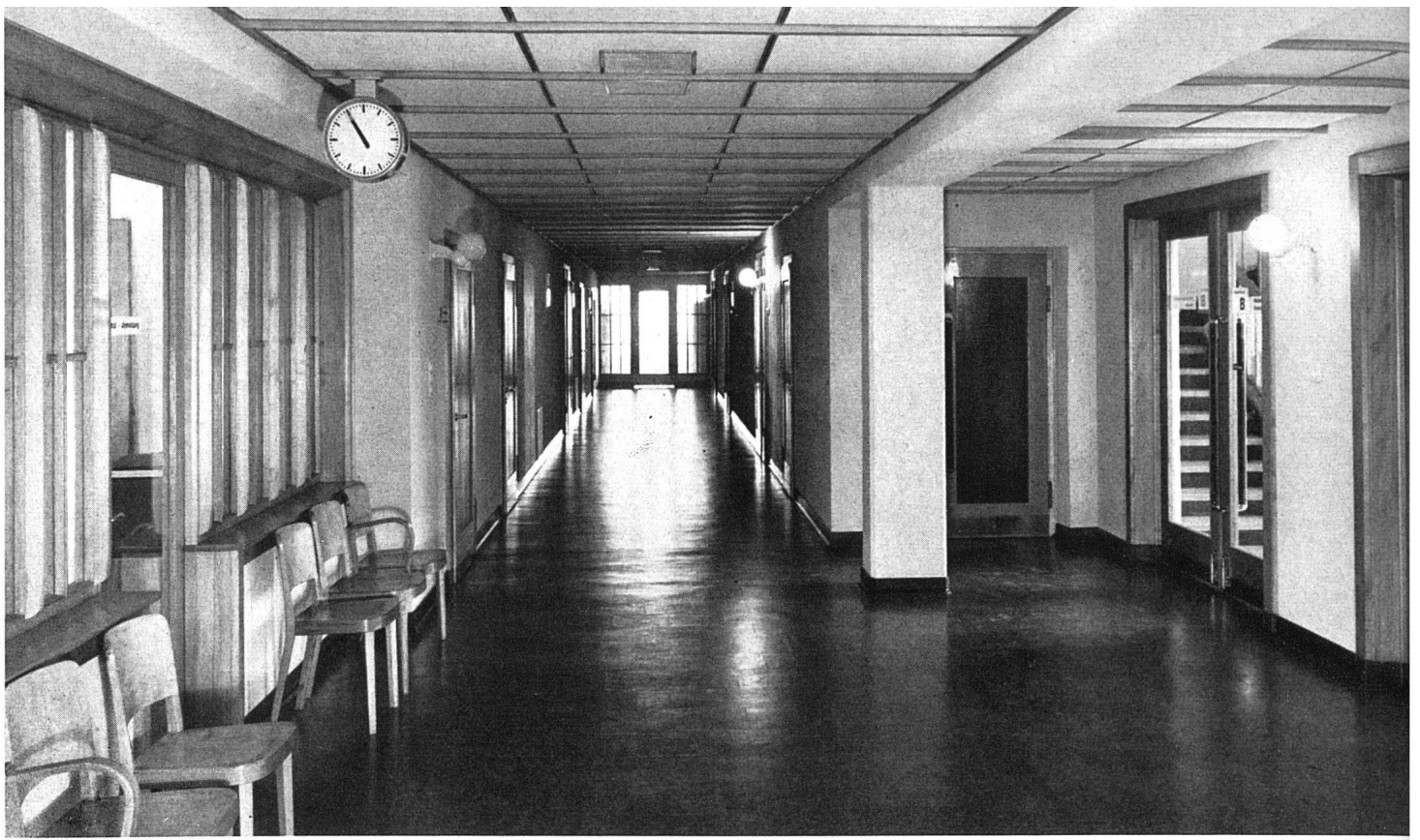
Abb. 45 Normalkorridor beim Anschluß des zukünftigen Bettenhauses. Die Decken sind hier gegenüber der normalen Raumhöhe von 3,00 m 2,45 m als demontable Paneele (Pavatex mit Naturholzrahmen) herabgesetzt (Hohlraum für Leitungen, Verringerung des Nachhalls, räumlicher Kontrast zu den Zimmern). Bodenbelag aus Korkplatten
