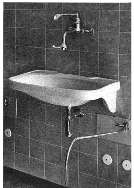
Abb. 82 Operationswaschtisch, neues flaches Modell AKZ (Fabrikat Kerawerke AG. Laufenburg) mit großem Wandabstand, auf 1,10 m Höhe montiert. Warmwassersparende Mischbatterie (Modell H. U. Bosshard AG.). Das Wasser fließt nur, so lange der Kniehebel bedient
