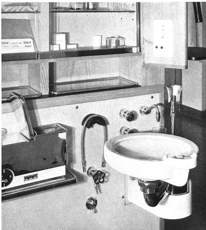
Abb. 73 Detail des Behandlungsplatzes der Ohren-Nasen-Hals-Klinik mit schwenkbarem Spuckbecken AKZ
