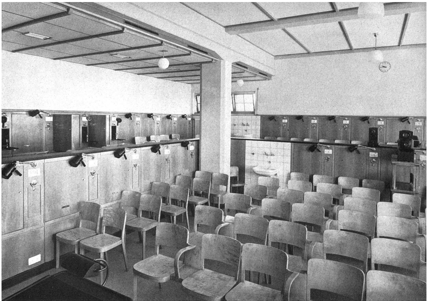
Abb. 64 Hörsaal und Spiegelkurssaal. Durch Aufklappen von Wandteilen (siehe Rückwand links) entstehen Untersuchungskojen
