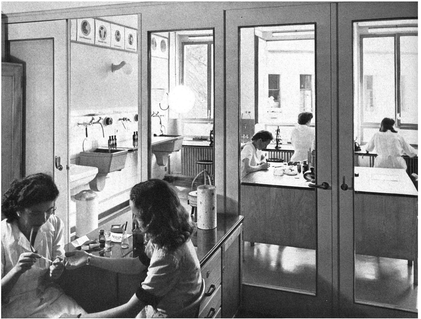
Abb. 72 Haematologisches Labor mit Vorraum für Patienten. Links säurefester Wandausguß AKZ (Fabrikat Steinzeugfabrik Embrach AG, Separation für Wasserstrahlpumpen)
