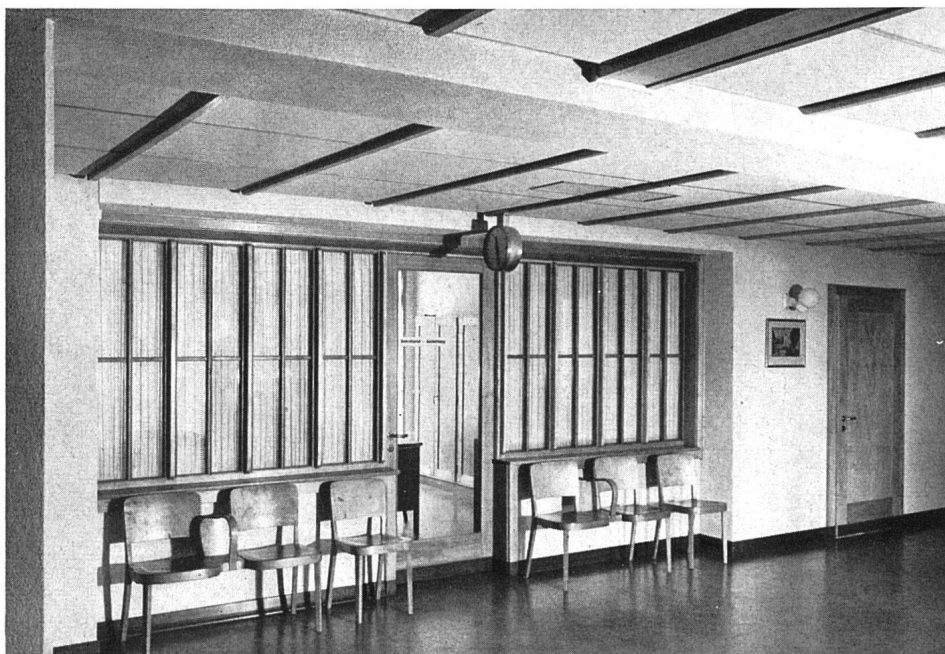
Abb. 47 Verglastes Sekretariat an Gangausweitung in der Gebäudeachse. Naturgebeizte Schreinerarbeit, bewußt kräftig profiliert
