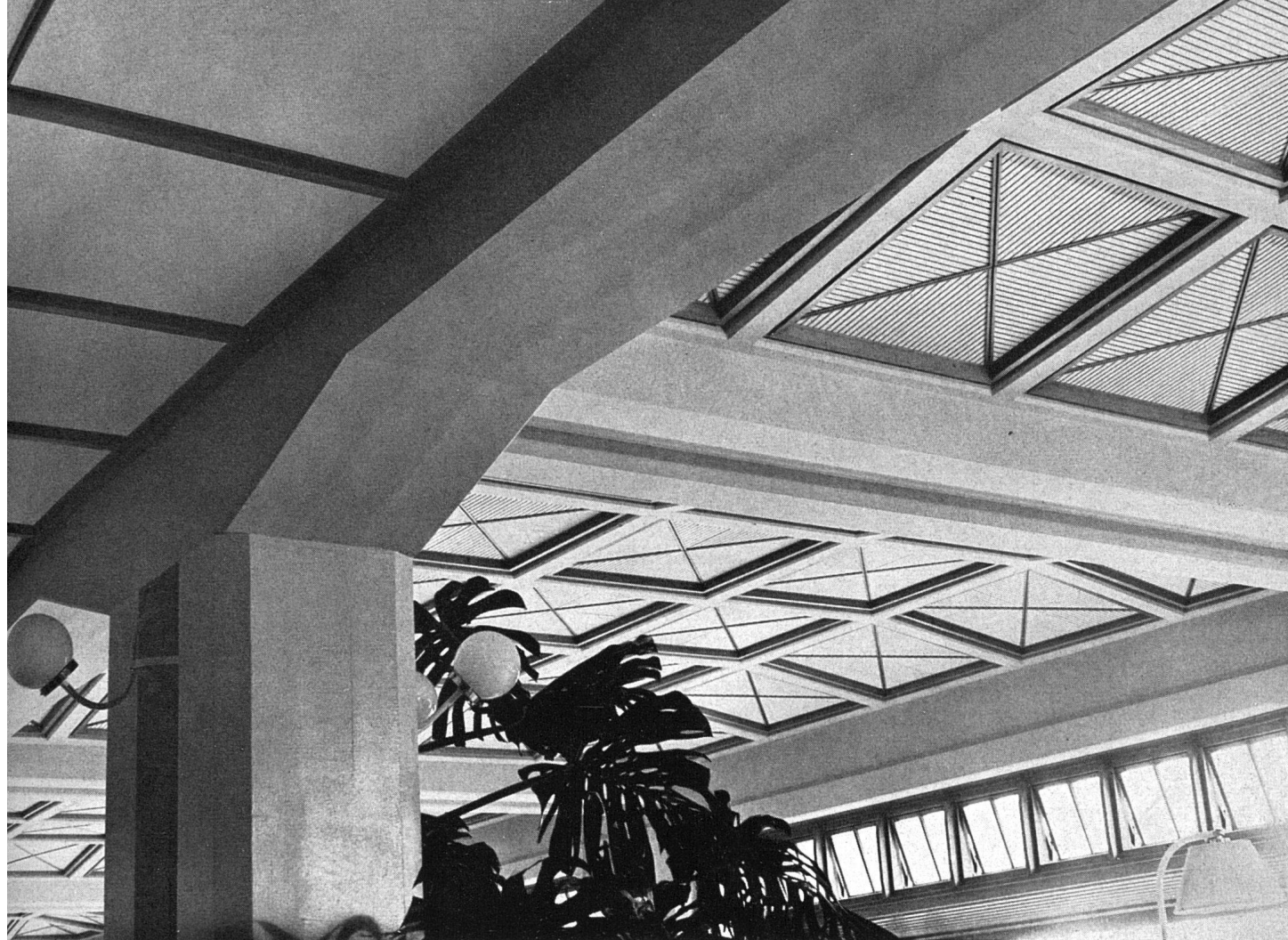
.42 Die Eisenbetonkonstruktion der Fassade erholt sich auch im Innern des Eingangsges- ses. Schallschluckende Deckenfüllungen (Pa- nele mit Naturholzrahmen) vermeiden lästigen Schall
