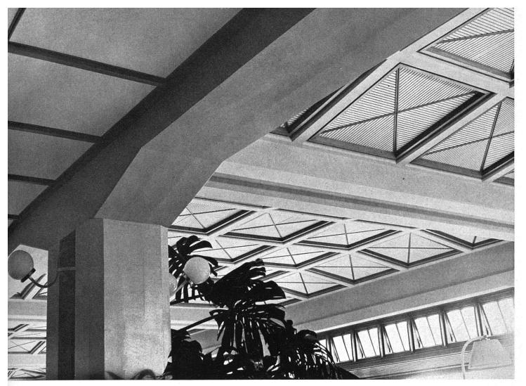
.42 Die Eisenbetonkonstruktion der Fassade erholt sich auch im Innern des Eingangsgesses. Schallschluckende Deckenfüllungen (Pav mit Naturholzrahmen) vermeiden lästigen hall
