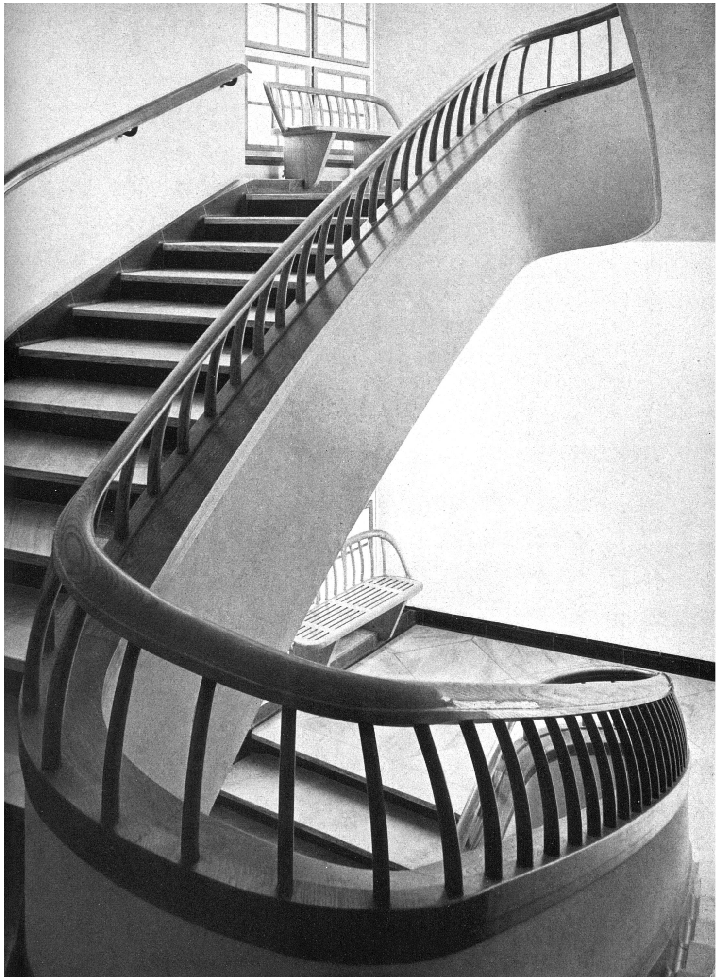
Abb. 49 Haupttreppe zu den Polikliniken, besonders bequem ausgebildet (für behinderte und ältere Patienten). Die Podestwände sollen Wandbilder aufnehmen (siehe Kunstteil). Helle Castione-Platten kontrastieren mit schwarzglänzenden, weichmodellierten Sockeln und Wangen. Geländer aus hellem Eschenholz
