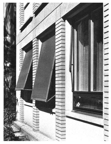
Abb. 30 Fenster von auβen. Der Rolladen ist ohne Öffnen des Fensters in verschiedenen Lagen ausstellbar. Modell AKZ (Patent H. Kiefer, Otelfingen)
