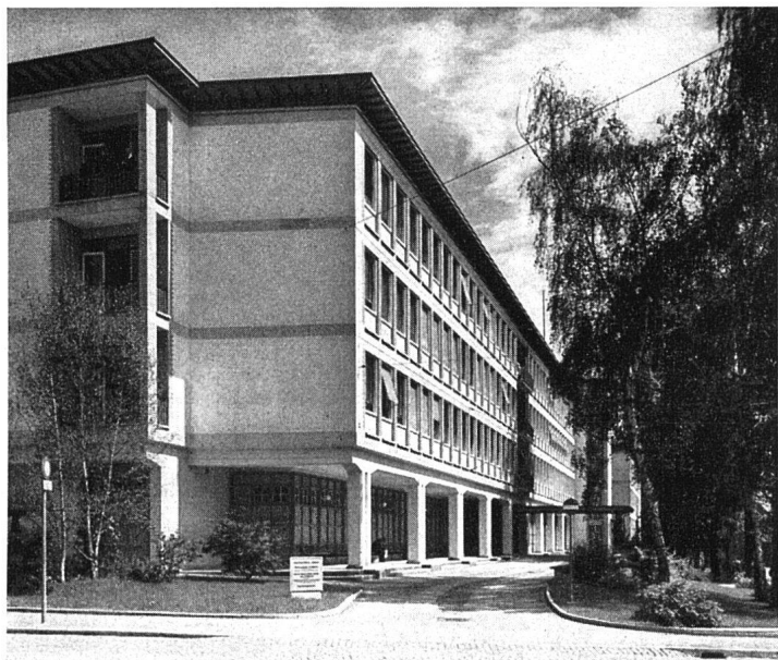
Abb. 37 Stirnfront des Nordbaus mit offener Besucherhalle
