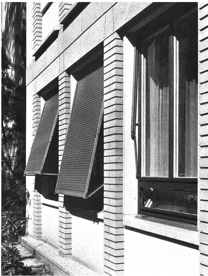
Abb. 30 Fenster von außen. Der Rolladen ist ohne Öffnen des Fensters in verschiedenen Lagen ausstellbar. Modell AKZ (Patent H. Kiefer, Otelfingen)
