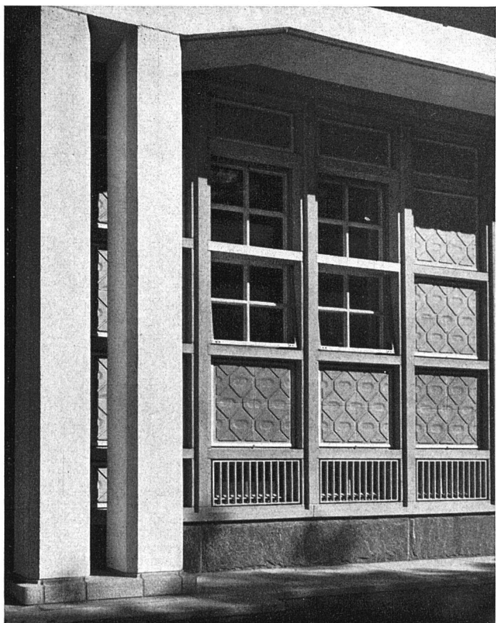
Abb. 38 Teilansicht der nichttragenden Außenwand des Geschosses A mit Betonraster. Füllungen mit Klinkerplatten verblendet
