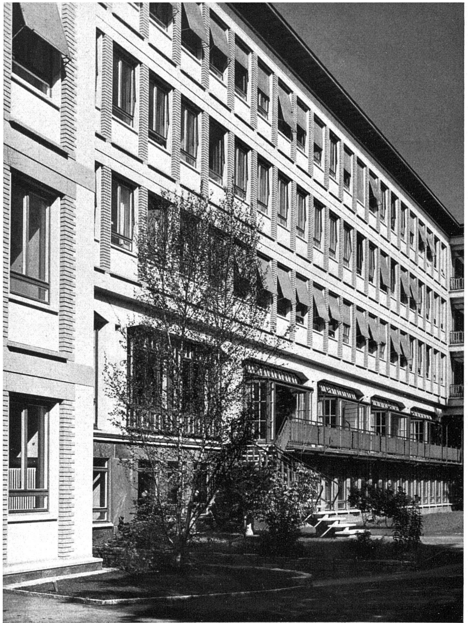
Abb. 39 Gartenfront mit Austrittsbalkon vor der Besucherhalle
