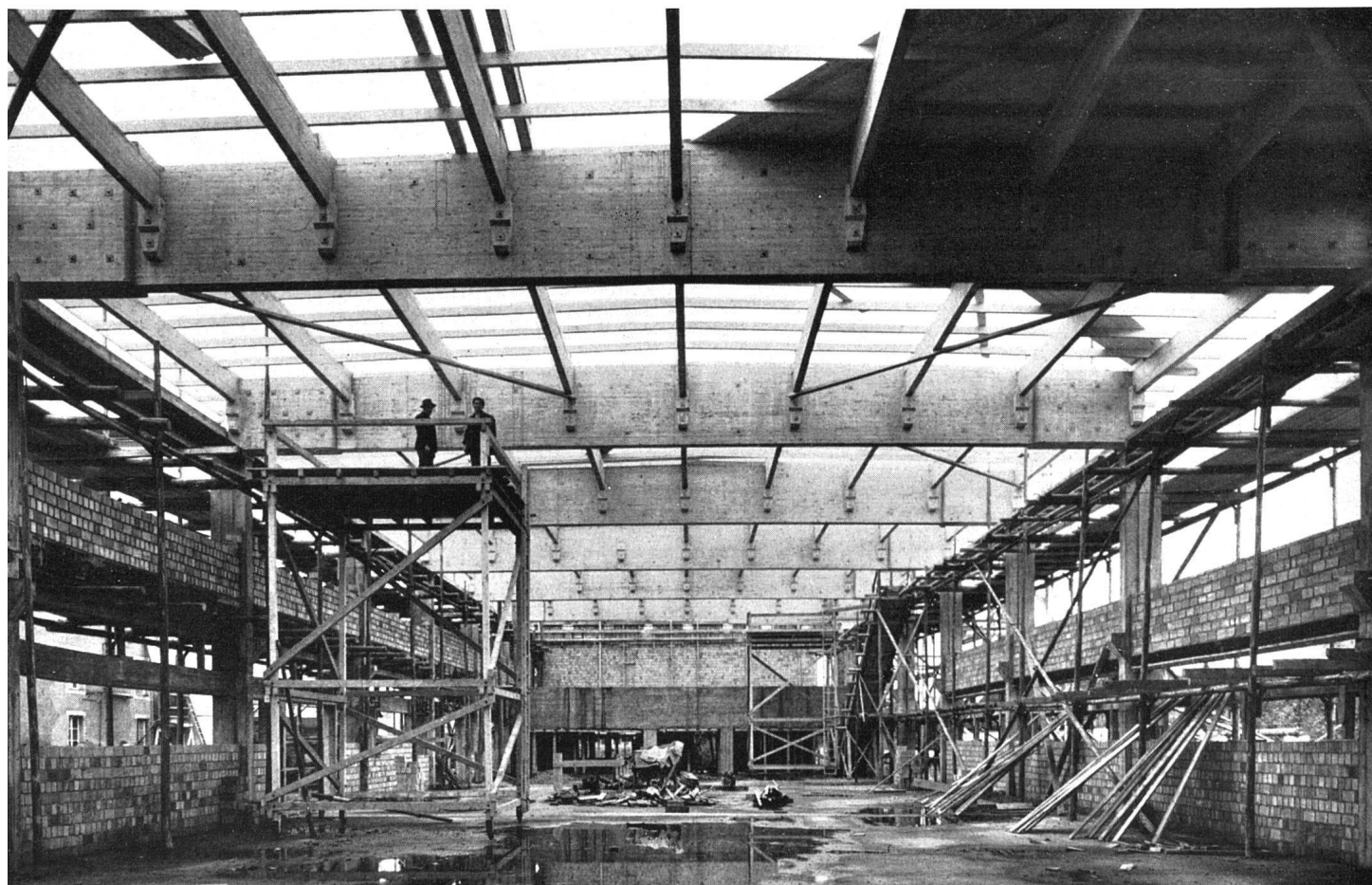
Lagerhalle im Rohbau, Verleimte Binder und Balken, Spannweite 16 m
