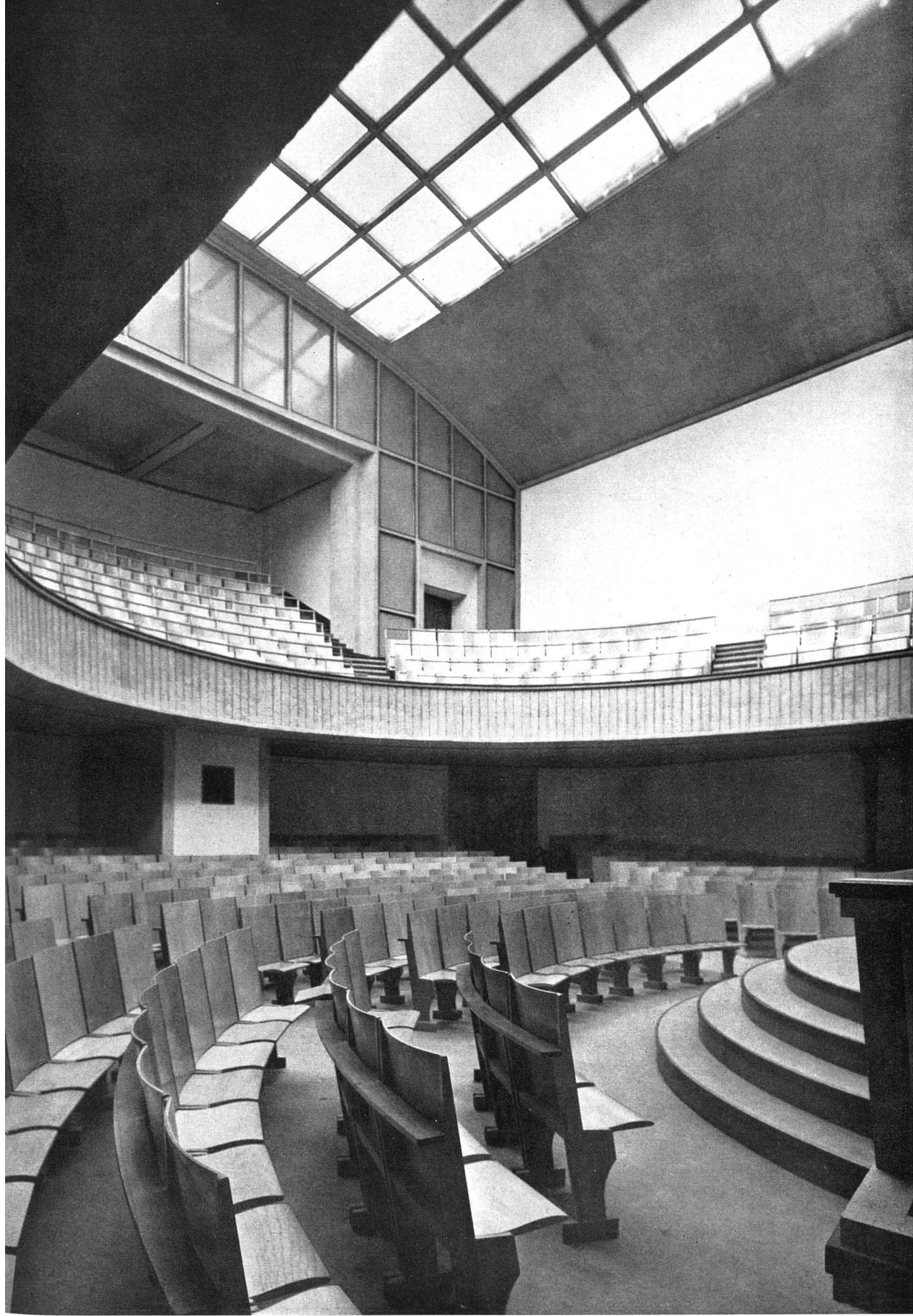
sur le parterre et le balcon. La balustrade est exécutée en béton apparent, les panneaux de recouvrement du mur de fond et du plafond sont en eplaque (bois de hêtre)
