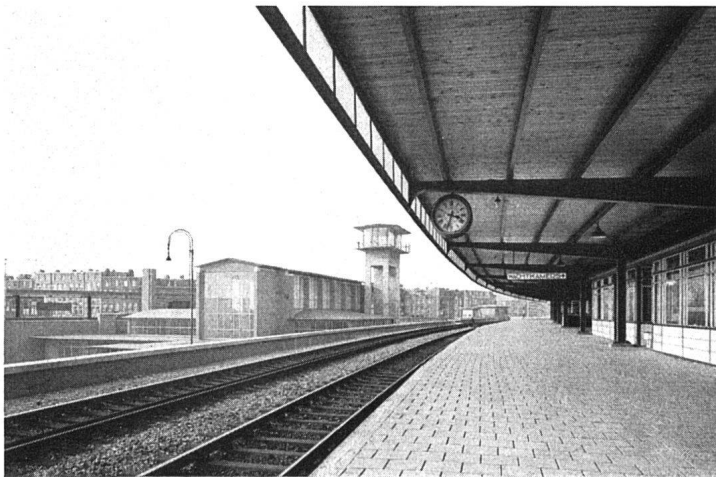
Bahnperron, Aufnahmegebäude mit Stellwerk
