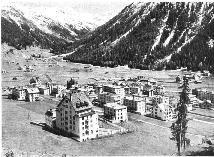
Abb. 8 Bebauung auf dem Schiabach-Kegel bei Davos (heutiger Zustand)
