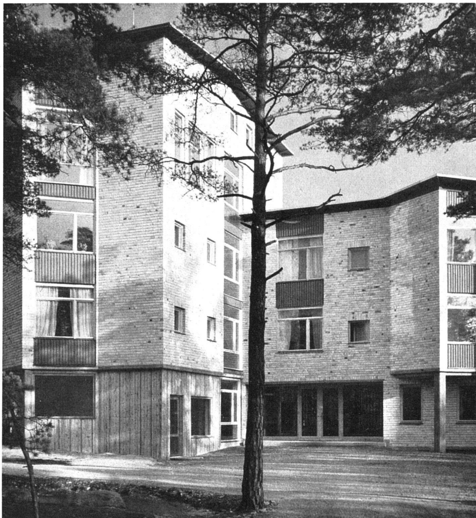
Haupteingangspartie, links Untergeschoß in Sichtbeton ausgeführt
