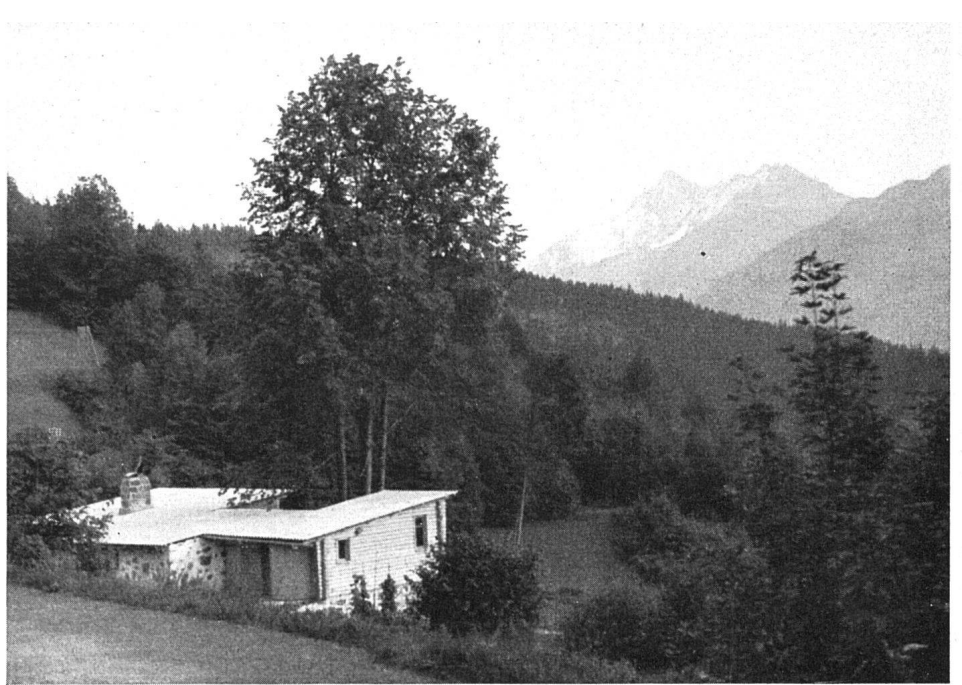
Das Haus von Nordwesten gesehen Das Dach ist mit Welleternit eingedeckt
