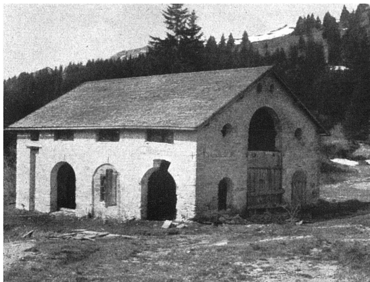
Die alte Tuffsteinsägeerei vor dem Umbau
