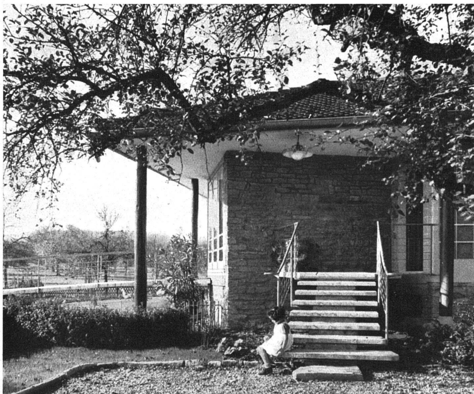
Hauseingang mit Natursteinmauer, Tragpfosten aus Rundholz
