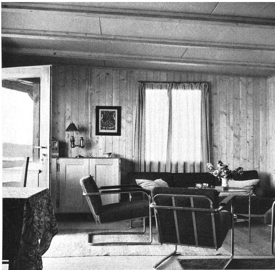
Wohnraum mit Sitzecke. Das Fastäfer der Wände ist roh, die Deckenfelder sind mit Pavatexplatten verkleidet
