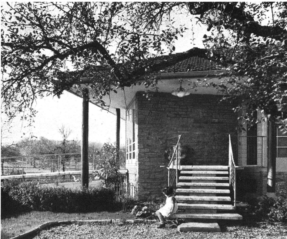
Hauseingang mit Natursteinmauer, Tragpfosten aus Rundholz
