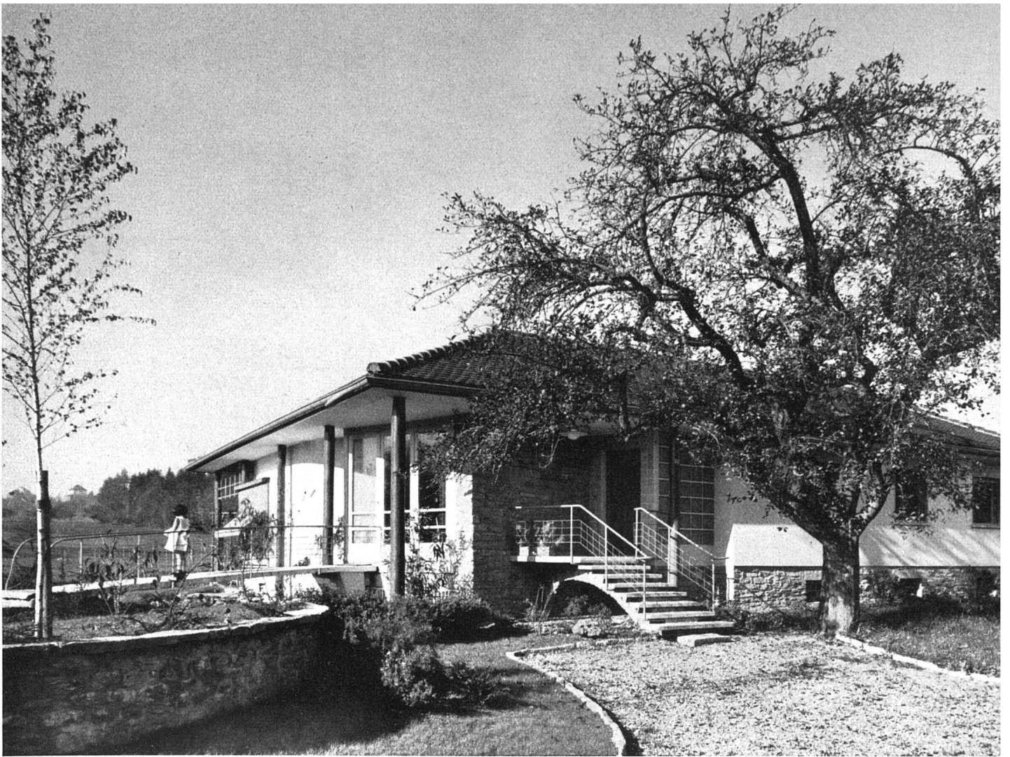
Gesamtansicht von Süden mit Hauseingang, rechts Schlaftrakt
