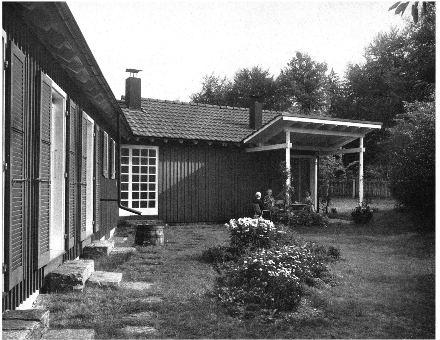
haus in Bern, Architekt BSA Hans Brechbühler, Bern. Gartenfronten: links Schlaftrakt, rechts Wohnraum mit Sitzplatz. Das Haus ist in vedisch-Rot gestrichen Photo: F. Henn SWB, Bern
