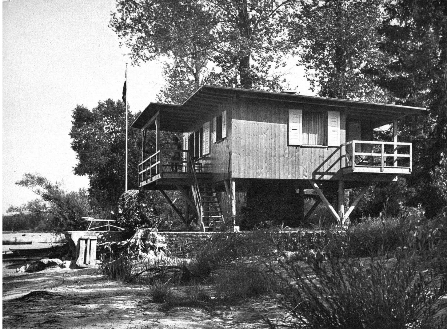
Gesamtansicht von Norden. Das Haus steht auf Stützen, weil es sich im Überschwemmungsgebiet des Murtensees befindet
