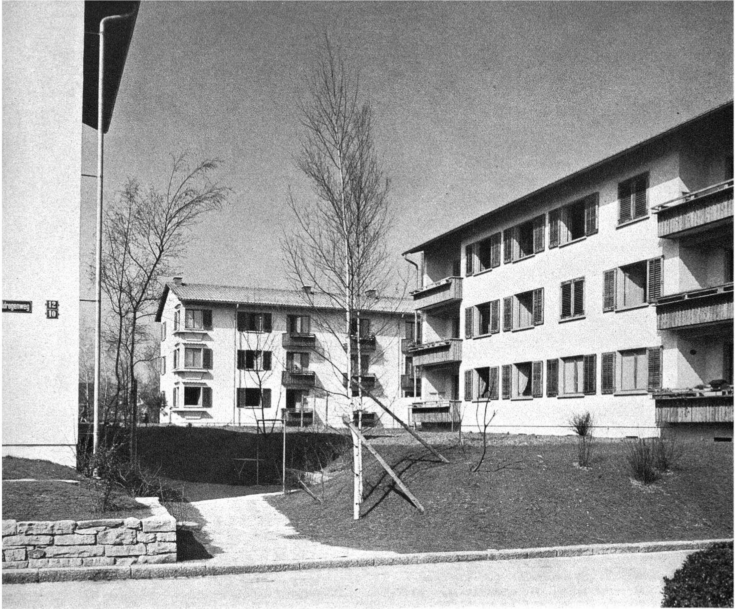
Siedlungsraum mit Mehrfamilienhäusern, rechts Ost-West-Typ, im Hintergrund Nord-Süd-Typ
