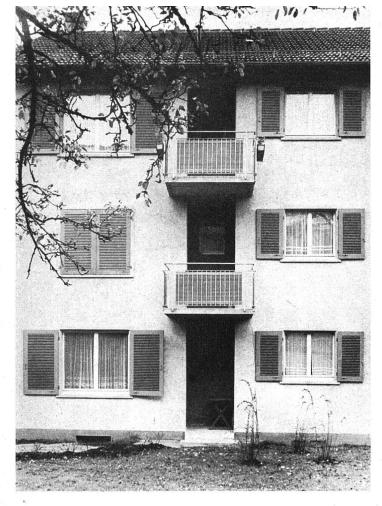
Fassadenausschnitt Balkon mit wegnehmbaren Schutzschirmen aus Rolladenpanzern
