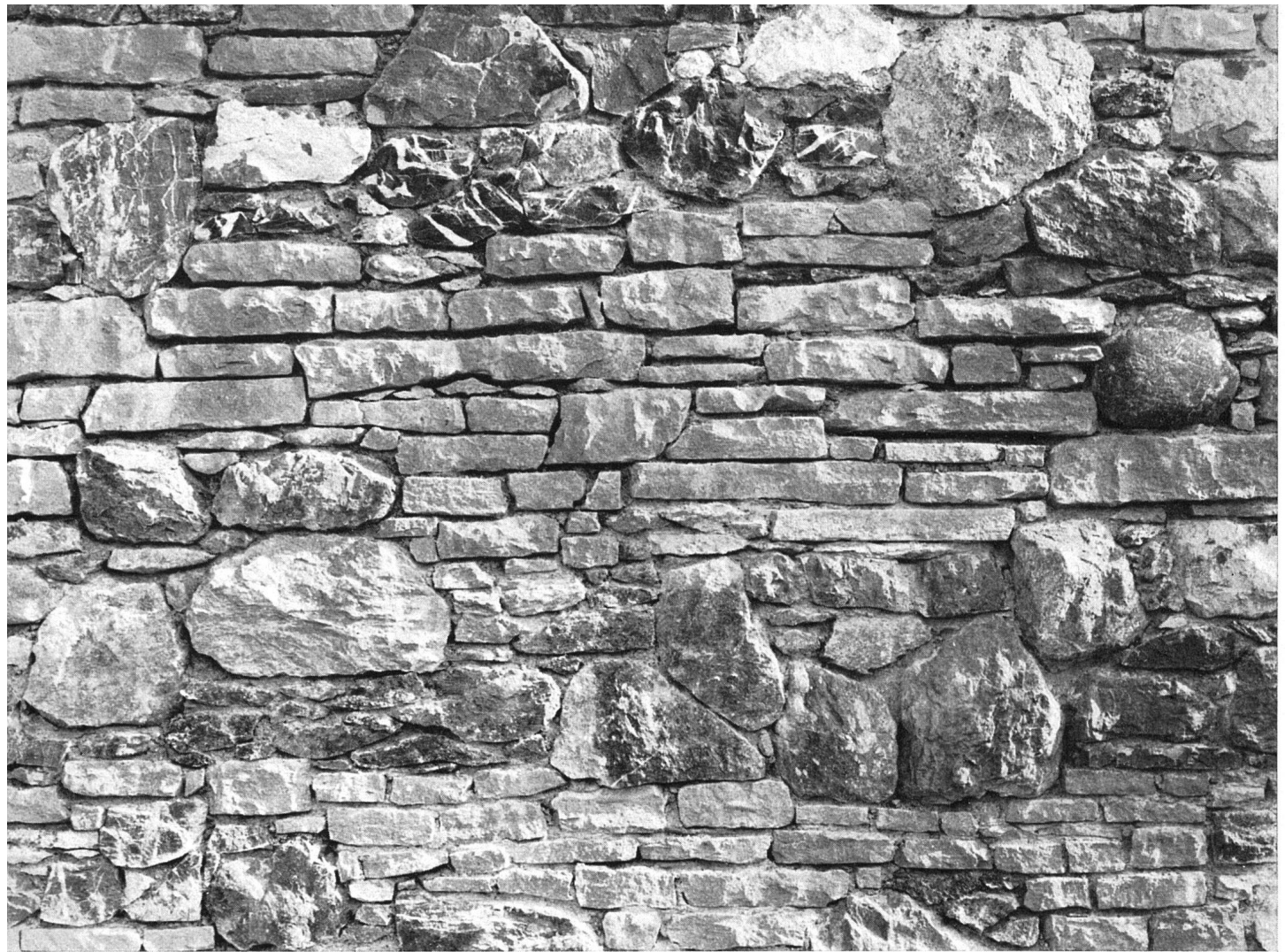
Schnitt aus einer Gartenmauer, grau-grüne Sandsteine, durchsetzt von roten und grauen Ackersteinen, aus nahem Moränenhügel stammend umann, Gartenarchitekt BSG, Thalwil
