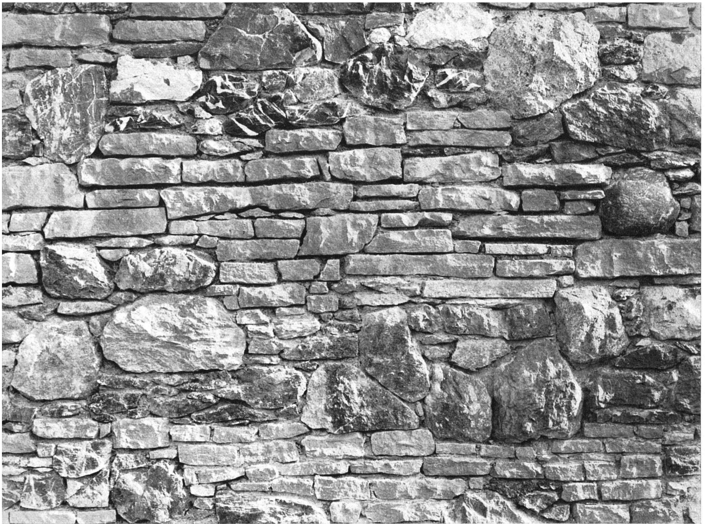
Querschnitt einer Gartenmauer, grau-grüne Sandsteine, durchsetzt von roten und grauen Ackersteinen, aus nahem Moränenhügel stammend Baumann, Gartenarchitekt BSG, Thalwil
