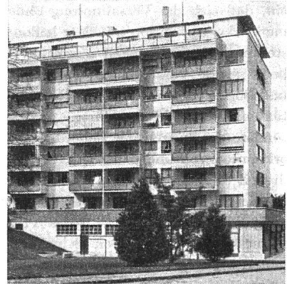
Immeuble Chemin de Roches, à Genève. Francis Quétant, arch. F.A.S., Genève
