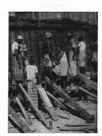
Betonieren der Kellerwände
