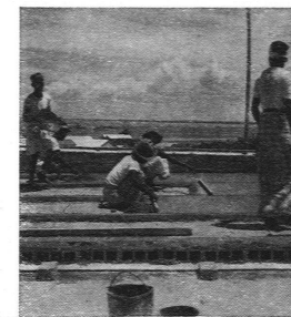
Dachterrasse, Verlegen der Tonplatten
