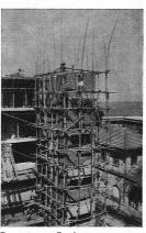
Baugerüst aus Bambusstangen
