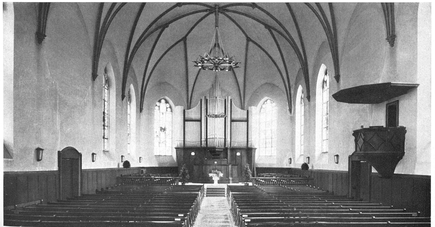
Der Kirchenraum vor der Renovation mit Gipsdecke und falschem Rippenwerk
