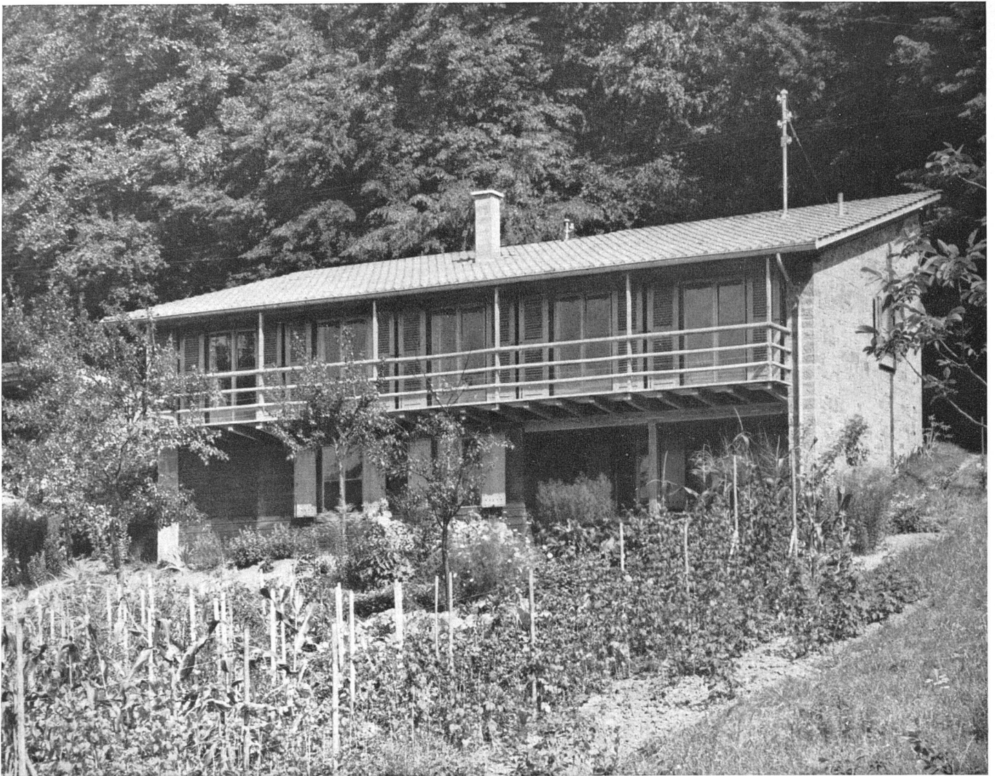
Gesamtansicht von Süden
