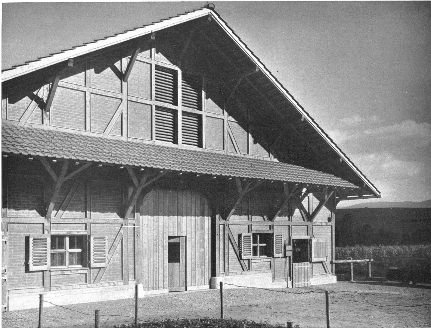
Westliche Giebelfront, unverputzter Riegelbau
