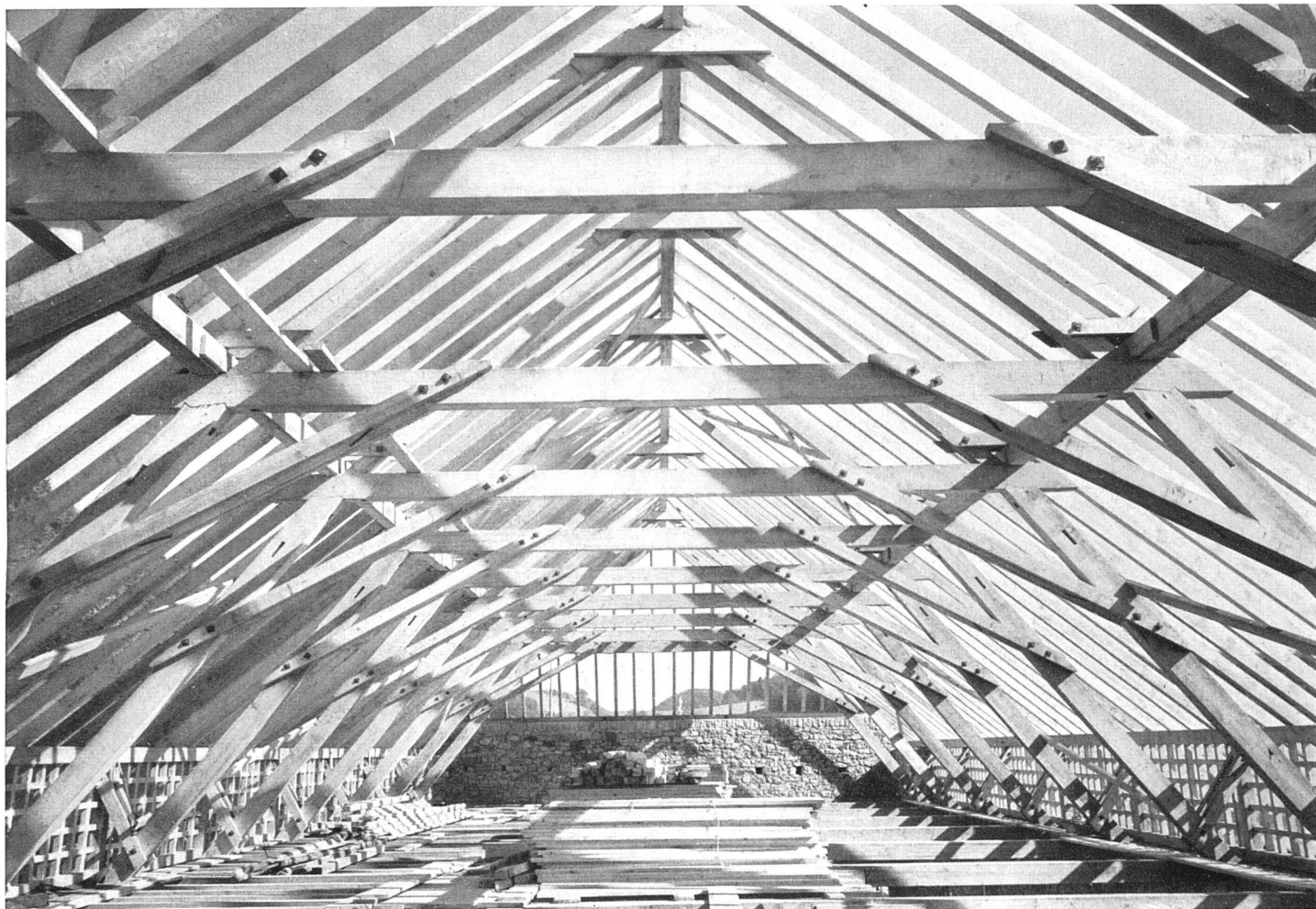
Dachstuhl und Balkenlage für Heuboden
