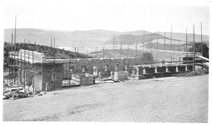
Scheune mit fertigem Bruchsteinmauerwerk Schalung für Futtersilos Blick gegen Süden
