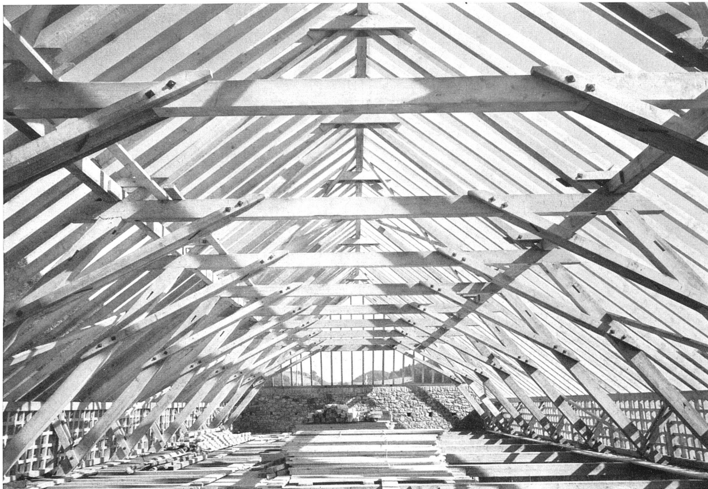
Dachstuhl und Balkenlage für Heuboden
