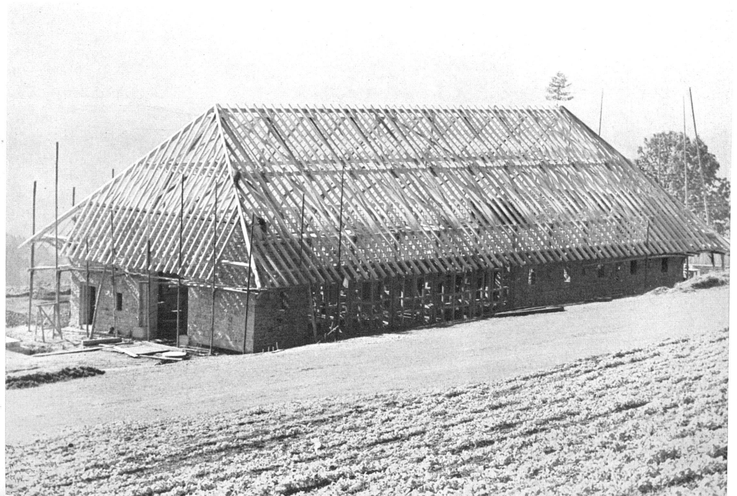
Scheune mit aufgerichtetem Dachstuhl
