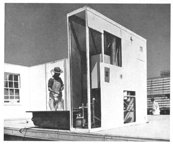
Wandelement mit fertig eingebauter sanitärer Installation, links für das Bad, rechts für die Küche
