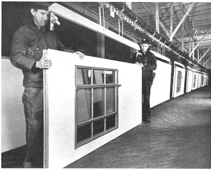
Fertige Wandelemente am fließenden Band
