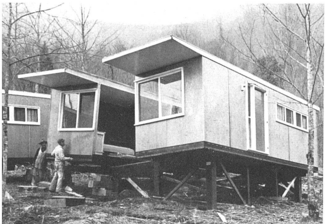
Ein in zwei Hälften fabriziertes Haus wird montiert
