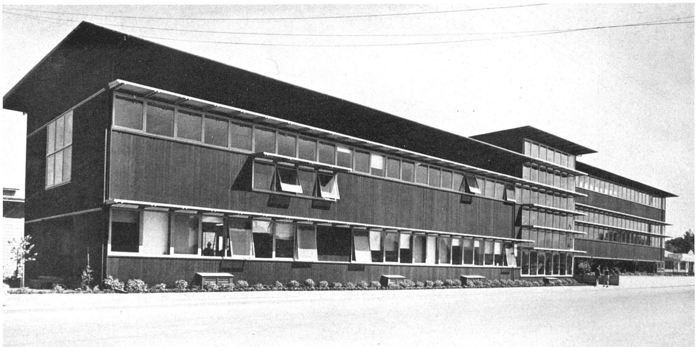
William W. Wurster Bürogebäude in Holz mit Sonnenschutzschirmen in Sunnyvale, California, 1942
