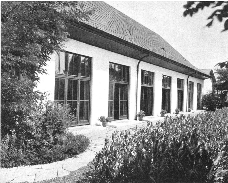
Wohlfahrtsgebäude der Waffenzabrik AG. Solothurn
