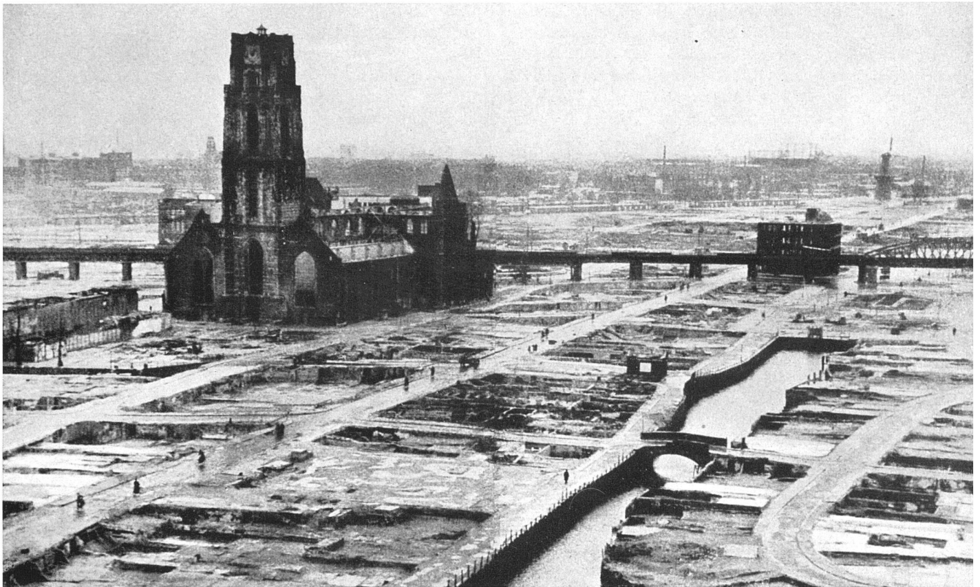
Rotterdam nach der Bombardierung durch die Deutschen am 14. Mai 1940. Ein Quartier von 32 000 Einwohnern wurde niedergelegt und inzwischen von den Holländern abgeräumt. Die 500 Jahre alte «Grote Kerk» ist eine Ruine. Die Neuplanung setzt eine großzügige Zusammenlegung d privaten Parzellen voraus
