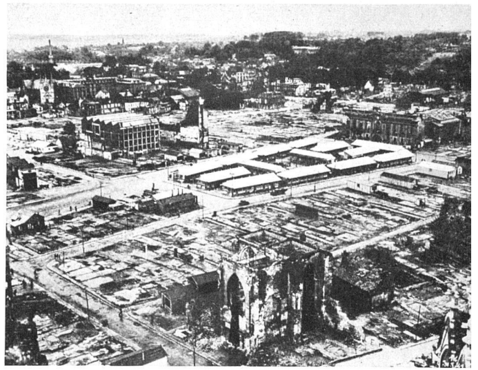
Abb. 7 Roubaix (Frankreich). Teilweise ausgeführte Notsiedlung in zukünftiger Freifläche
