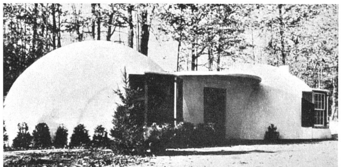
Abb. 10 Amerika. Behelfsheim in Spritzbeton mit Ballonschalung
