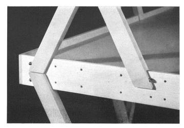
Detail, Stütze und Fixierung mit Aluminium-Splinten
