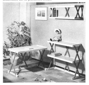
gen Breite der Streben übereinstimmt. Durch die Belastung der Tablare, die ein geringfügiges Spreizen der Streben bewirkt, wird das satte Ineinandergreifen der einzelnen Elemente noch erhöht. Es entsteht so ein vollkommen ausgesteiftes Ganzes, das, wie Versuche gezeigt haben, einer respektablen statischen Beanspruchung standhält. Man ist beim ersten Anblick dieser äußerst sparsam dimensionierten Einzelteile geneigt, diesen Möbeln die effektiv mögliche Beanspruchung überhaupt nicht zuzutrauen.
