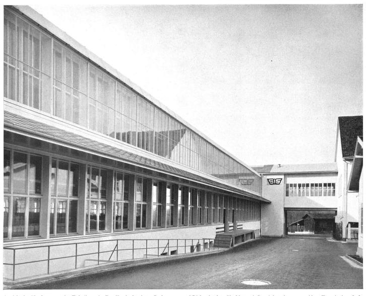
$Ansicht \ des \ Neubaus \ von \ der \ Fabrikstra \beta e. \ Das \ Vordach \ schützt \ Laderampe \ und \ Lichtschächte. \ Shedfirst \ mit \ Spezialstücken \ aus \ wei \beta em \ Eternit \ eingedeckt$
