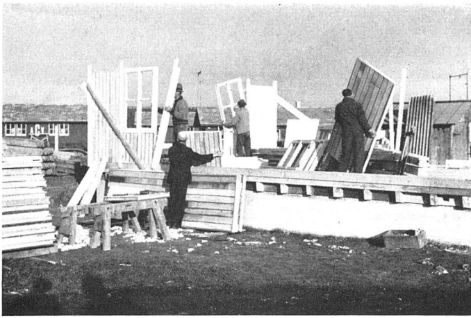
Der Montageverlauf Zustand um 9 Uhr
