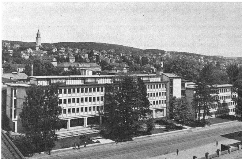
Der neue Polikliniktrakt des Kantonsspitals Zürich Photo: M. Wolgensinger SWB, Zürich
