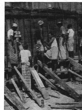
Betonieren der Kellerwände
