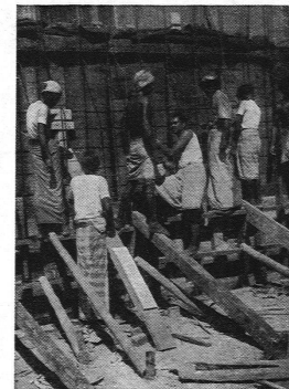
Betonieren der Kellerwände
