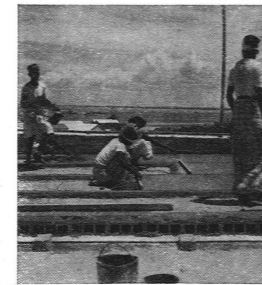
Dachterrasse, Verlegen der Tonplatten
