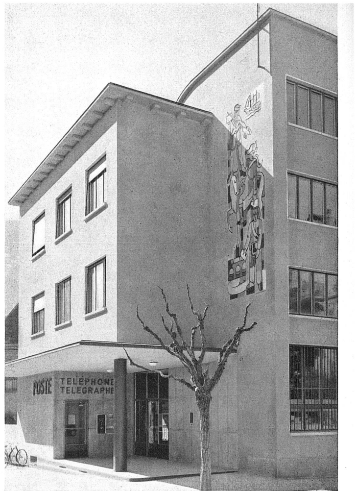
Eingang, Wandbild von A. Neuenschwander
