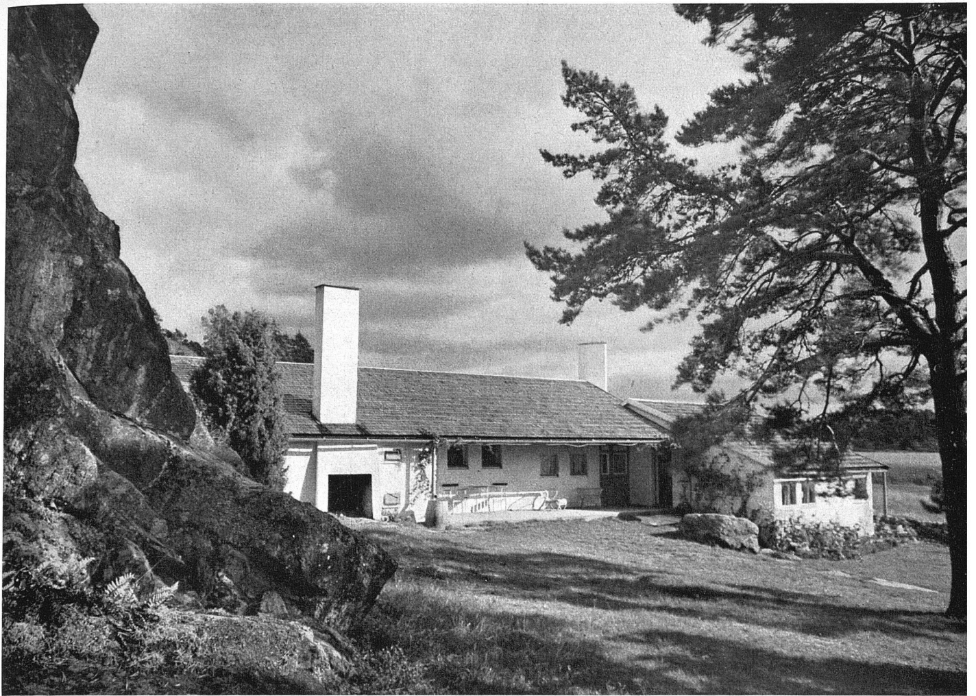
Gesamtansicht von Westen, links der offene Kamin
