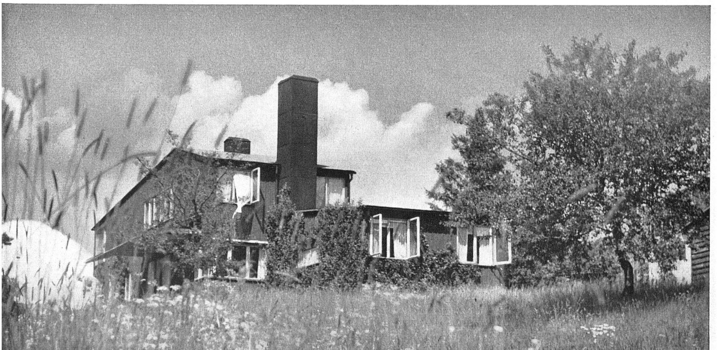
Teilansicht von Südosten
