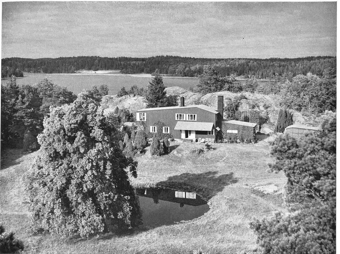
Gesamtansicht von Süden, das Haus ist rostrot gestrichen
