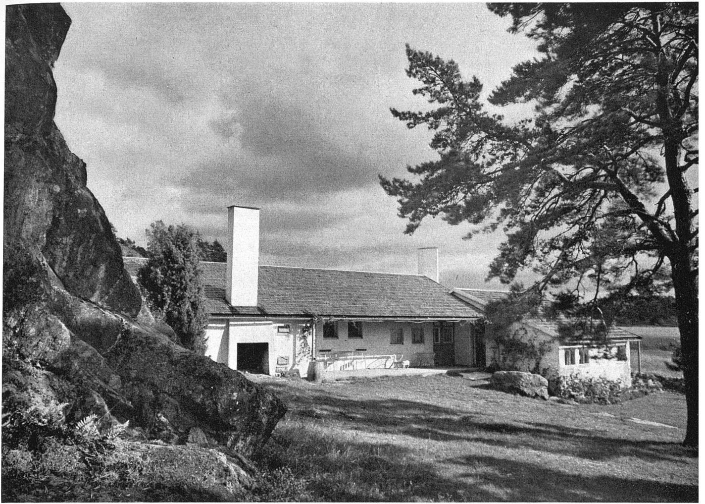
Gesamtansicht von Westen, links der offene Kamin
