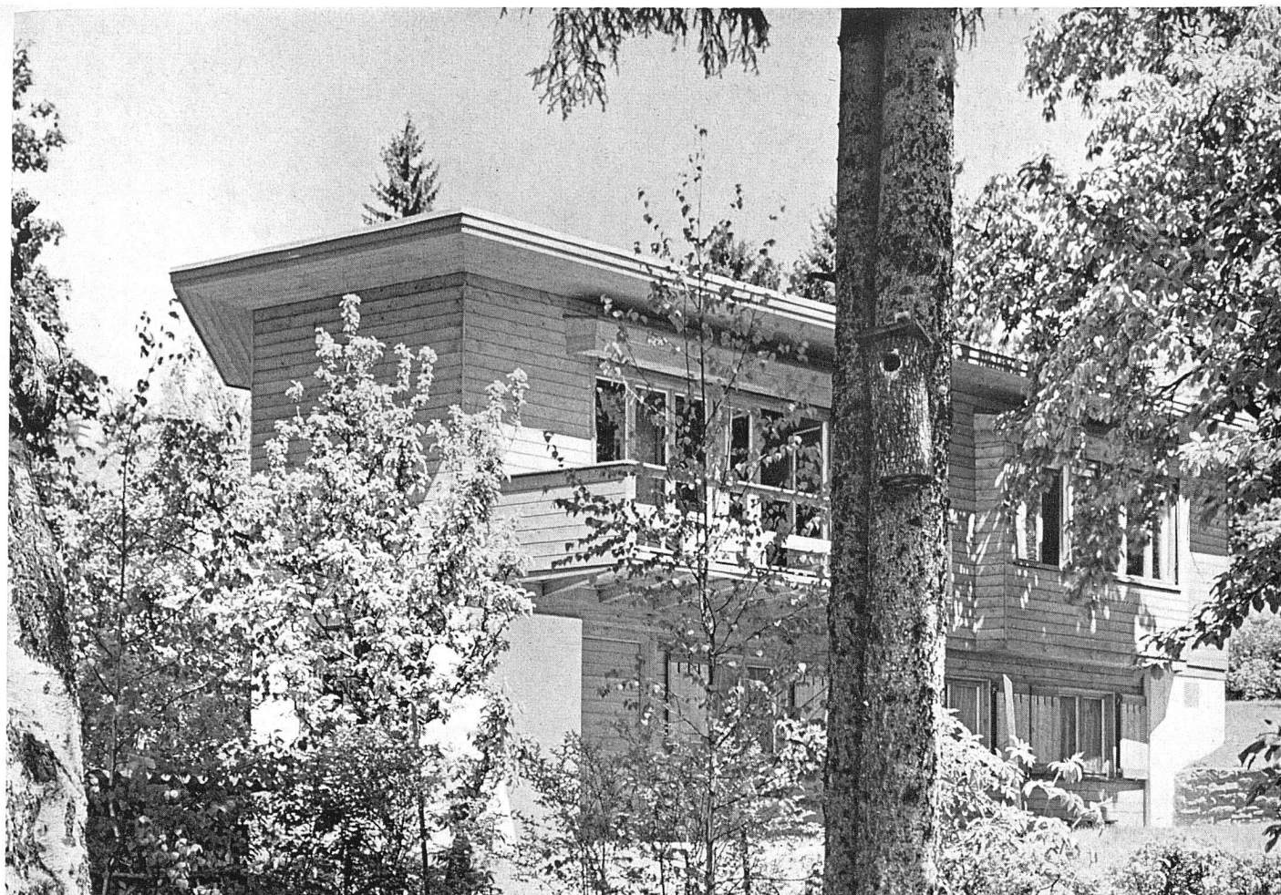
Gesamtansicht von Süd
