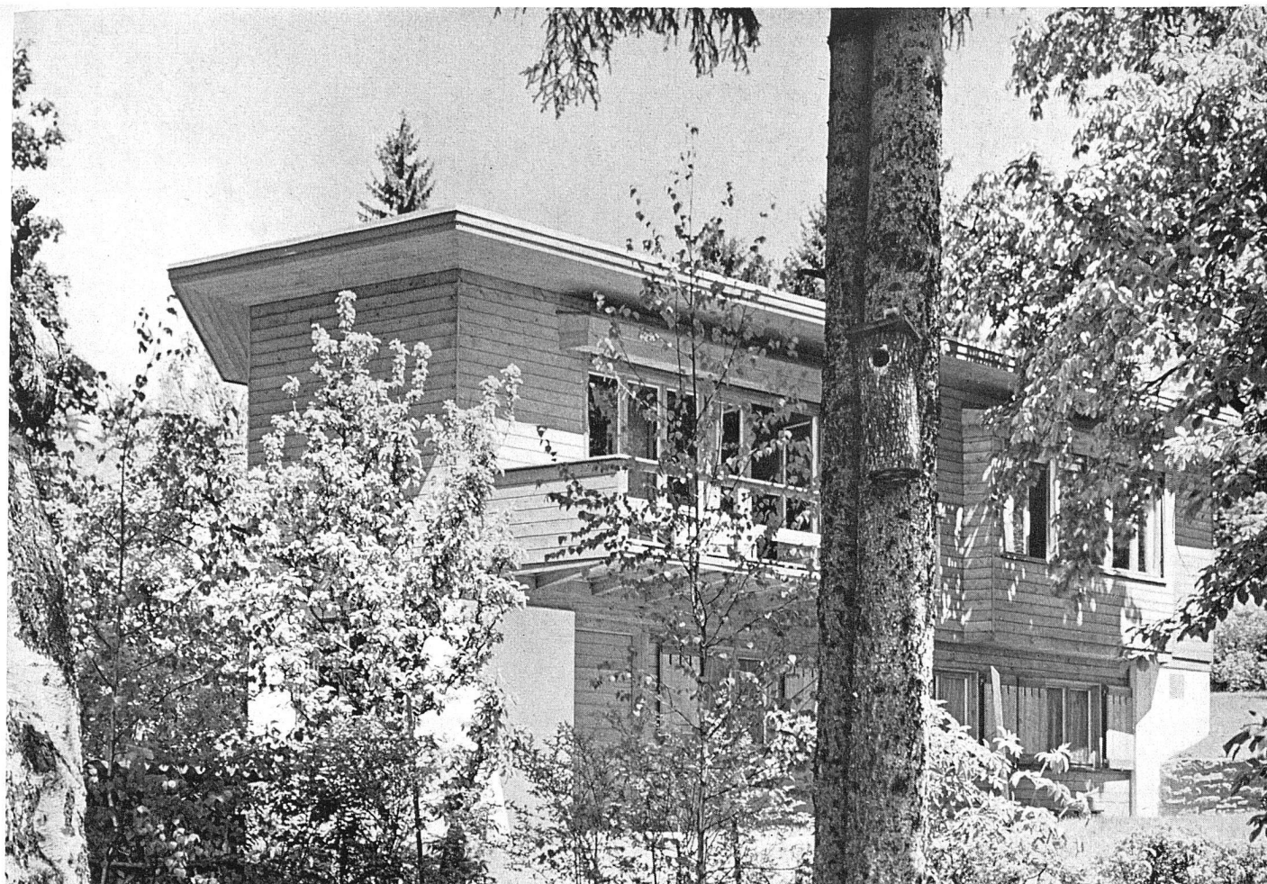
Gesamtansicht von Süd
