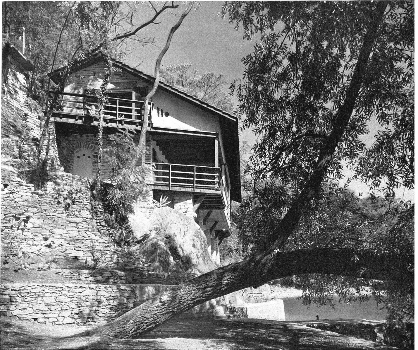
Ferienhaus bei Ascona Architekt BSA Alfred Altherr, Zürich
