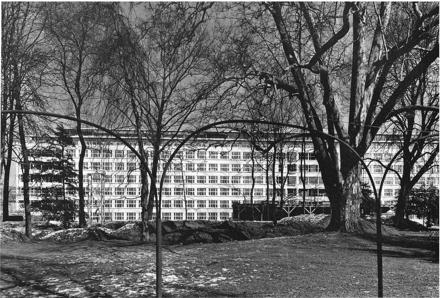
Blick auf das Bettenhaus durch den Park von Süden
