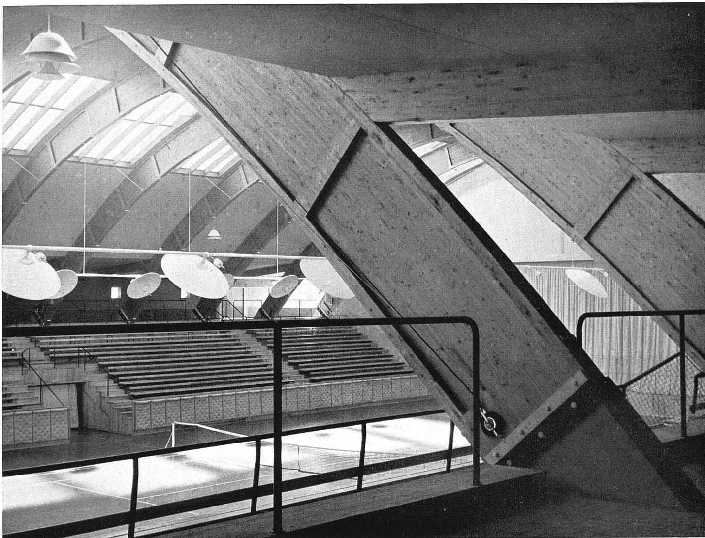
Innenansicht Verleimte «Törebodabinder» Spannweite 55 m
