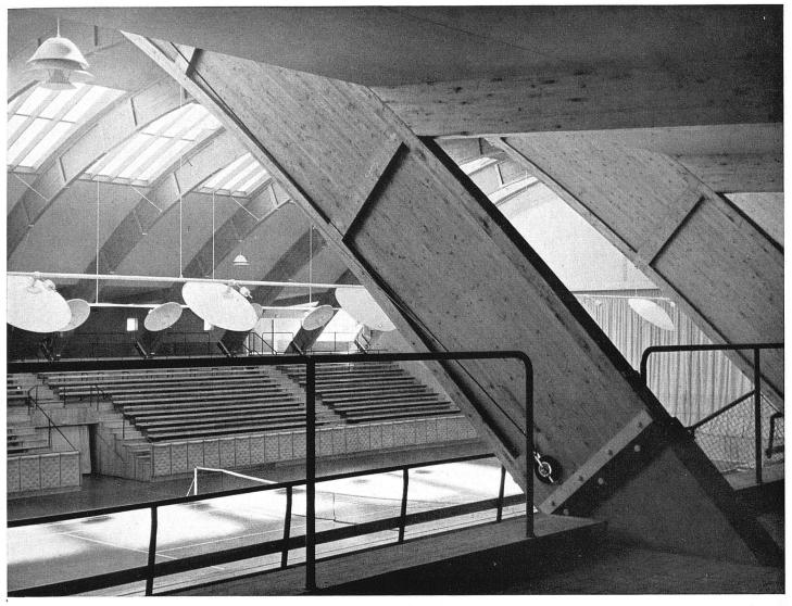
$Innenansicht \quad Verleimte \ \ {\it ``T\"{o}rebodabinder"} \quad Spannweite \ 55 \ m$
