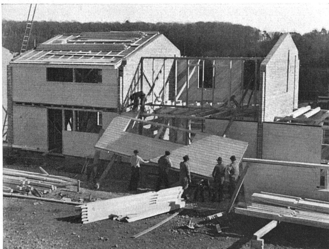
Montage eines Fassadenelementes
