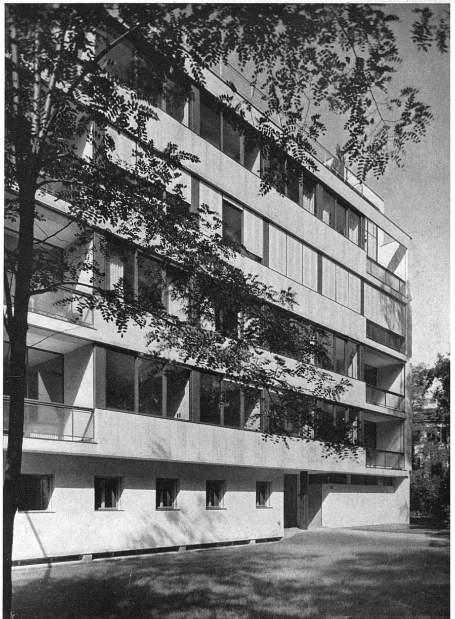
Ostfassade am Zossenwe
