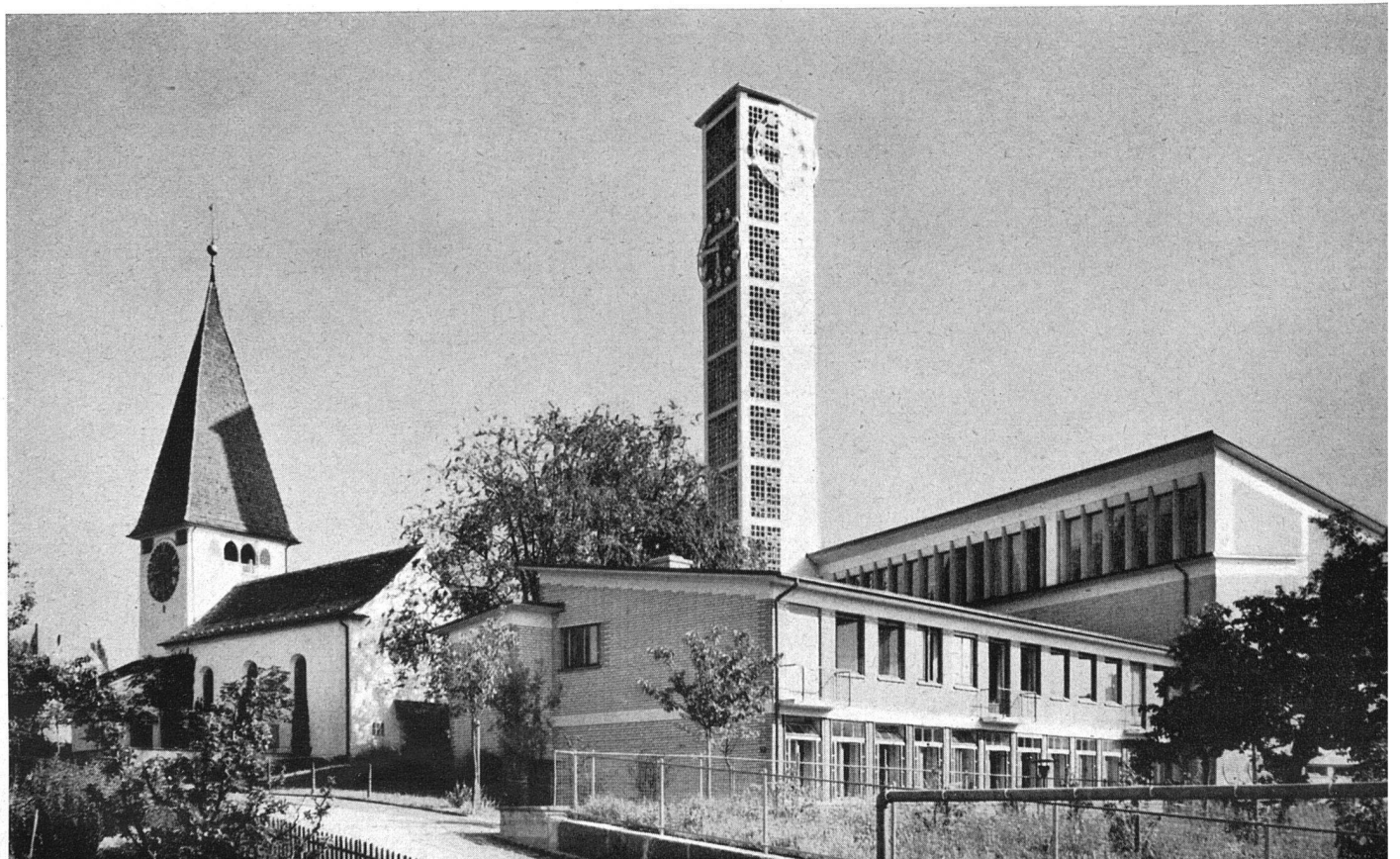
Abb. 3 Gesamtansicht von Nord
