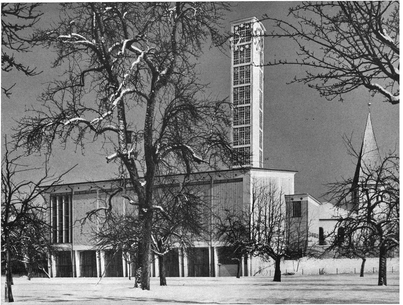
Abb. 2 Gesamtansicht von Süden mit Fensterfront des Gemeindesa
