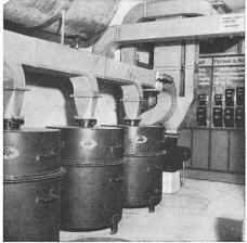
Filteranlage einer Gasschutzventilation
