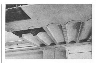
Monieta-Schilfrabitz für rißfreie Gipsdecken Doppelschilfrohrgewebe für Decken und Verkleidungen
