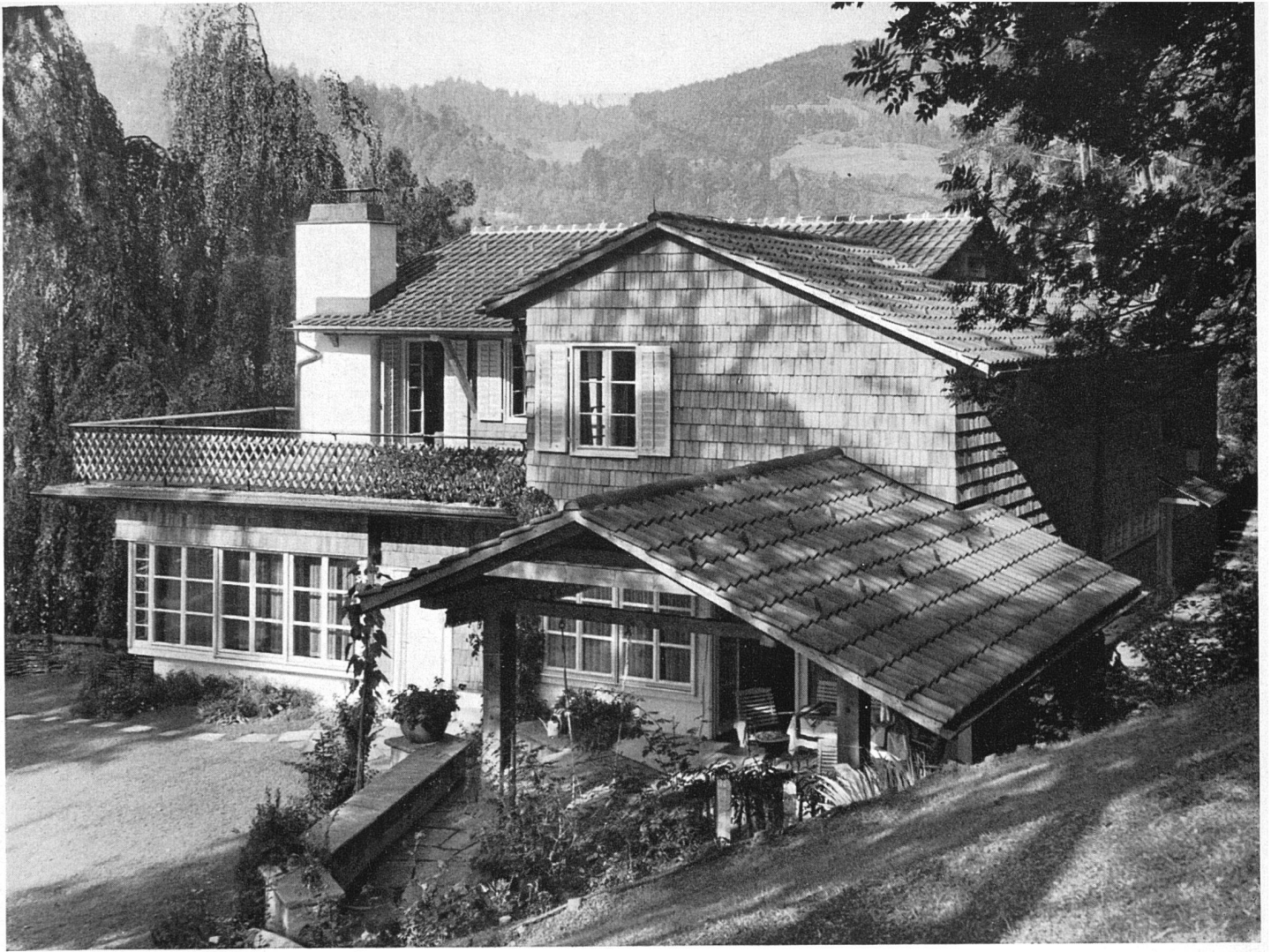
Gesamtansicht von Osten
