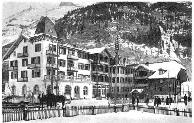
Noch ein Flügel — noch städtischer: vor allem der Terrassen-vorbau fällt als monumentaler Sockel aus der Tonart.
