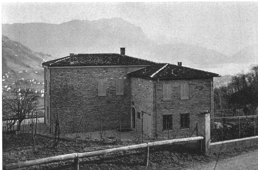
Facciata settentrionale, vista della strada
