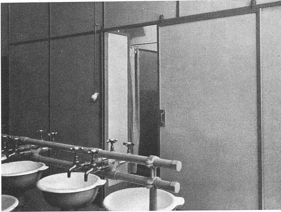
Eternit-Platten für steinharten, abwaschbaren Wandschutz, oder für Füllungen von Kabinen-Trennwänden und -Türen, Balkonbrüstungen und dergleichen.
