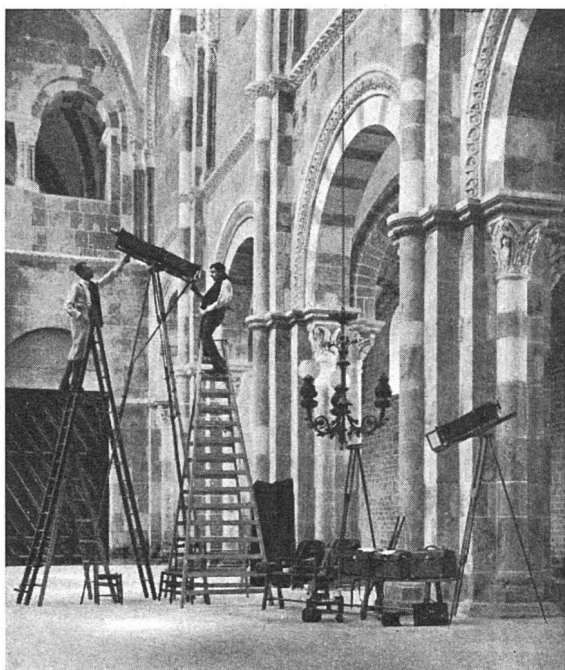
links: Aufnahme von Kapitellen in der Abteikirche von Vézelay, Burgund, mit der sog. «Marburger Kanone», einer Spezialkamera mit einer Objektivreweite von 100 cm, die es ermöglicht, noch die entferntesten Objekte detailliert aufzunehmen. rechts: Das Ergebnis der Aufnahme.
